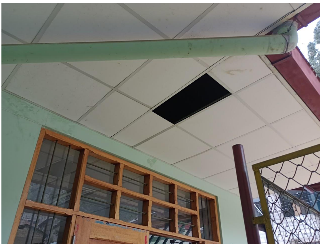
I.E Inicial Aymas – presenta techos en mal estado por humedad y desgaste
